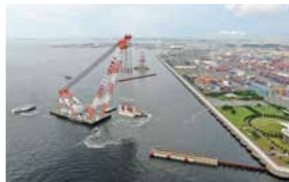
▲新本牧ふ頭ケーソン据付状況
