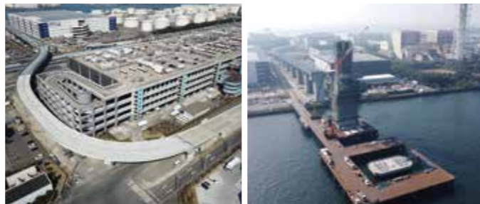
▲臨港道路東扇島水江町線整備の様子▲
