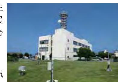
▲銚子地方気象台の露場と庁舎
