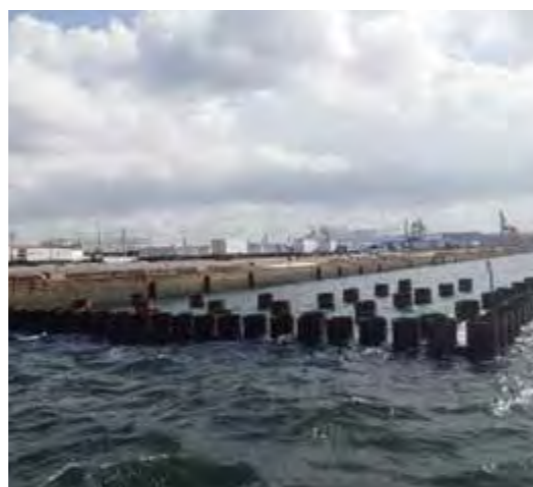
▲写真③ 施工状況(令和4年10月時点)
