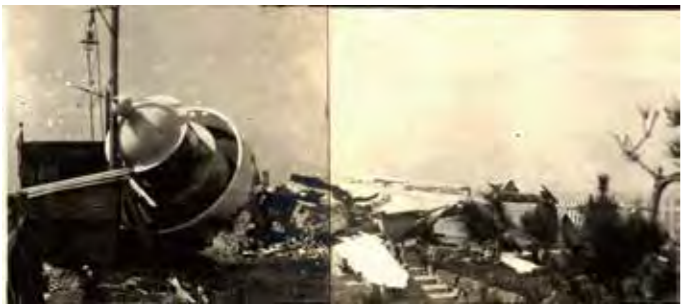
▲城ヶ島灯台の倒壊
