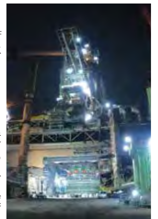
▲改修中の高炉外観
