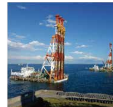
▲地盤改良工事
