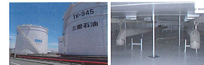
▲B: 固定屋根付浮屋根式 貯油タンクと内部の状況
