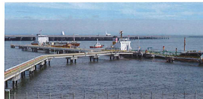
▲A: 専用棧橋で航空燃料を荷揚げするタンカーの状況
