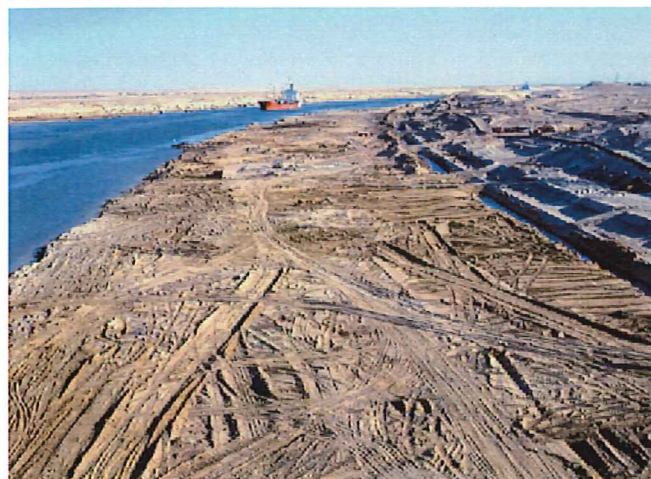
▲スエズ運河増深拡幅工事の状況
