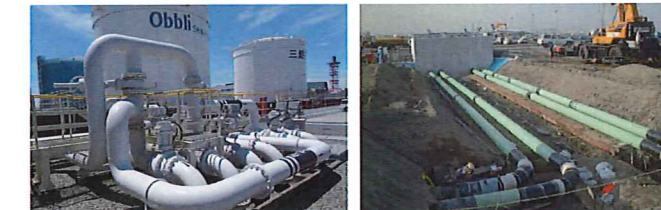
▲C: パイプラインと地下パイプラインの状況
