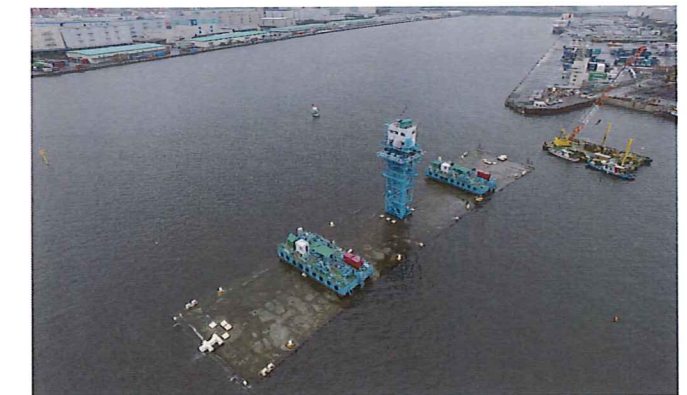
▲沈埋物浚渫工事の状況
