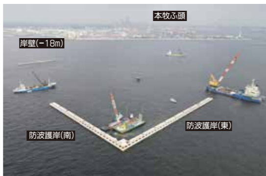
▲新本牧ふ頭地区工事箇所の全景(令和4年9月)
