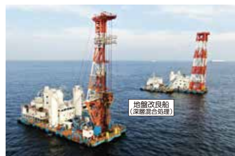
▲地盤改良工事の様子
