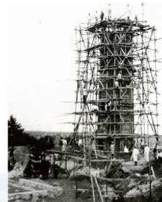
▲建設時の清水灯台
