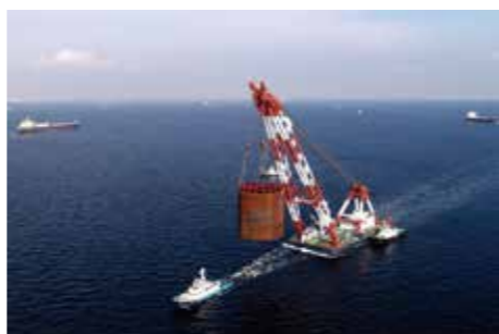
▲岸壁鋼板セルえい航の様子
