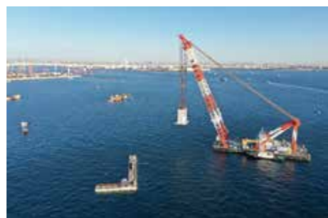
▲護岸ケーソン据付の様子
