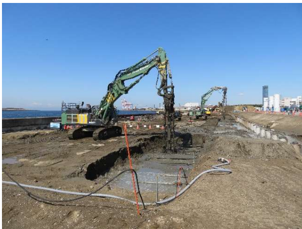
地盤改良(中層混合処理)状況写真
