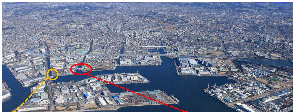
【西浦排水機場】
