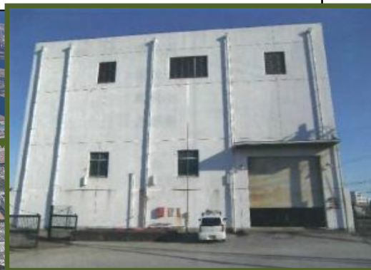
【白旗排水機場】
