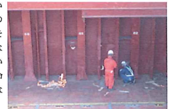
▲貨物倉の点検状況
