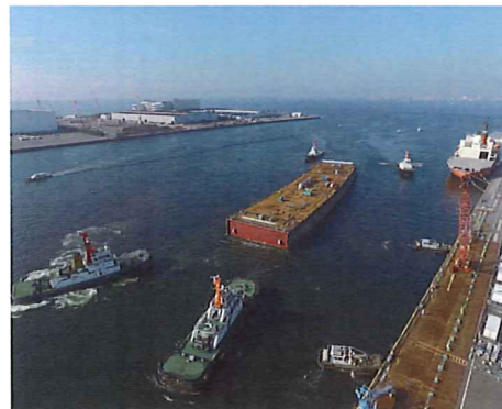
▲東京湾臨港道路南北線沈埋函の据え付け作業
