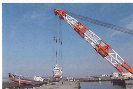
▲東北大地震・被災船撤去作業
