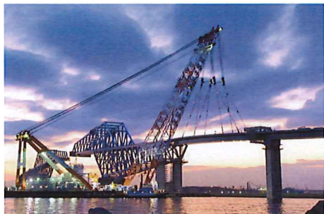
▲大型起重機船「富士」(3,000トン吊)による東京ゲートブリッジ架設作業
