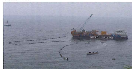
▲海底ケーブル工事
