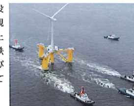
▲浮体式洋上風力発電施設の曳航作業
