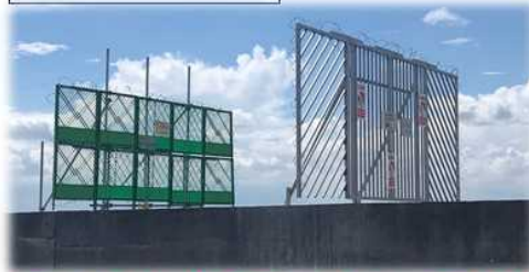
突堤内の状況 (令和3年6月撮影)
