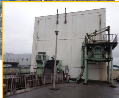
中央4号排水機場
