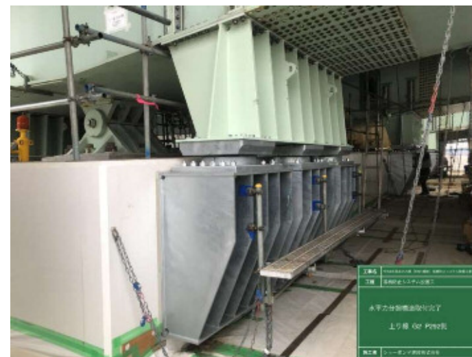
～現況(橋脚水平力分担構造設置後)～20
