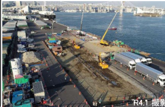
S3バース(施工中)
