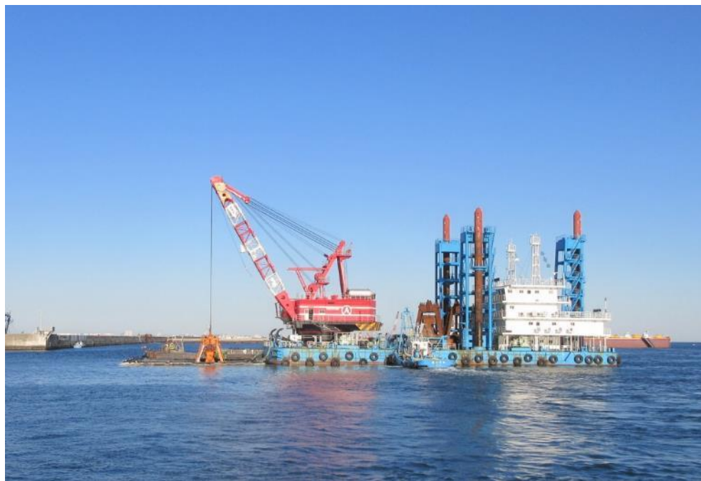
写真4 浚渫作業全景
