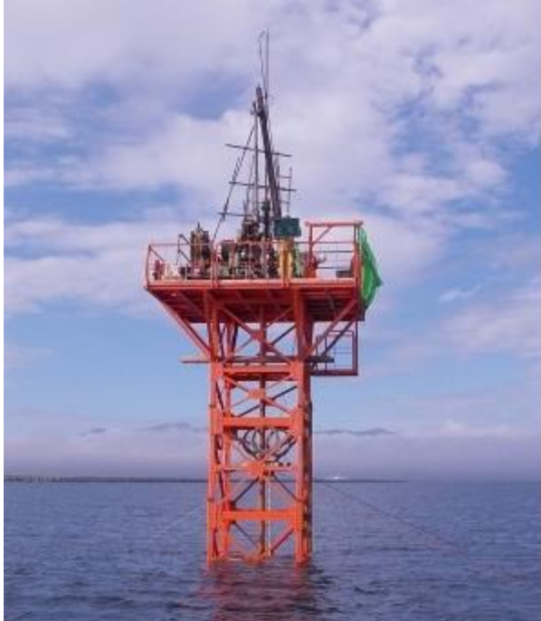
写真1 鋼製櫓設置状況
