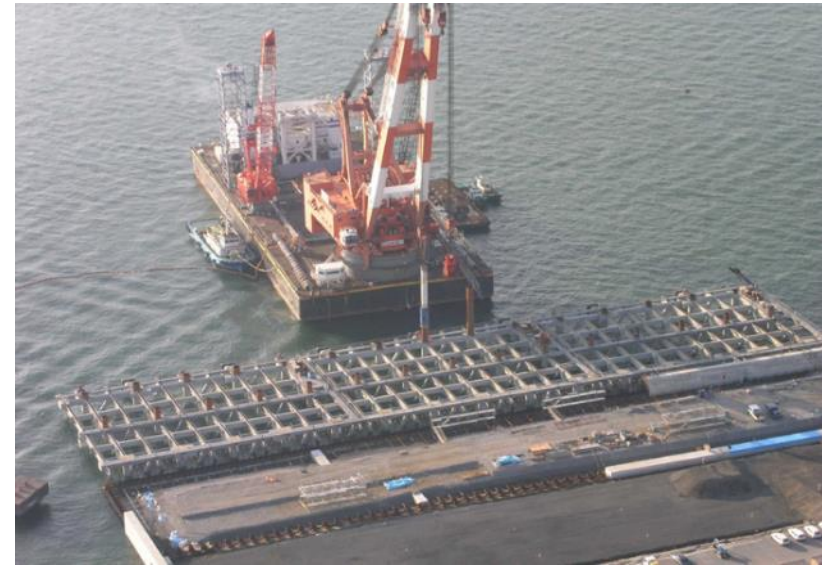
写真2 使用予定の起重機船による鋼管杭打設状況
