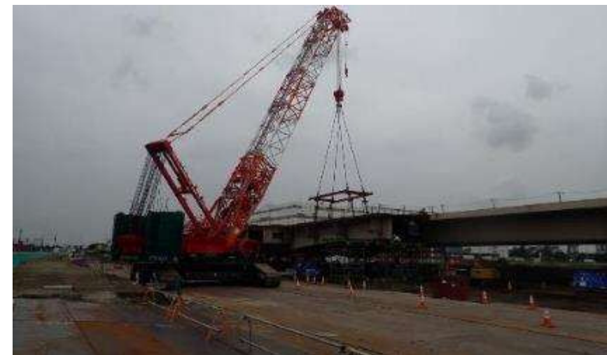
～(橋りょう撤去状況)～
