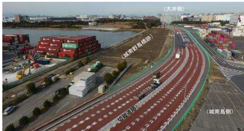
～現況(道路切り回し、橋梁撤去後)～
