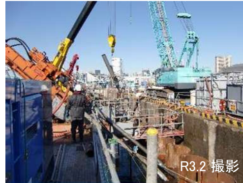
S3バース(施工中)
