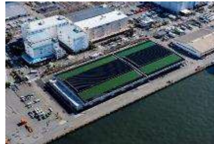
完成した上屋の状況
