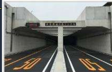
東京港海の森トンネル 陸上トンネル部（直轄）
