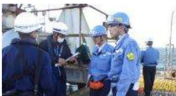
タンカーバース点検
